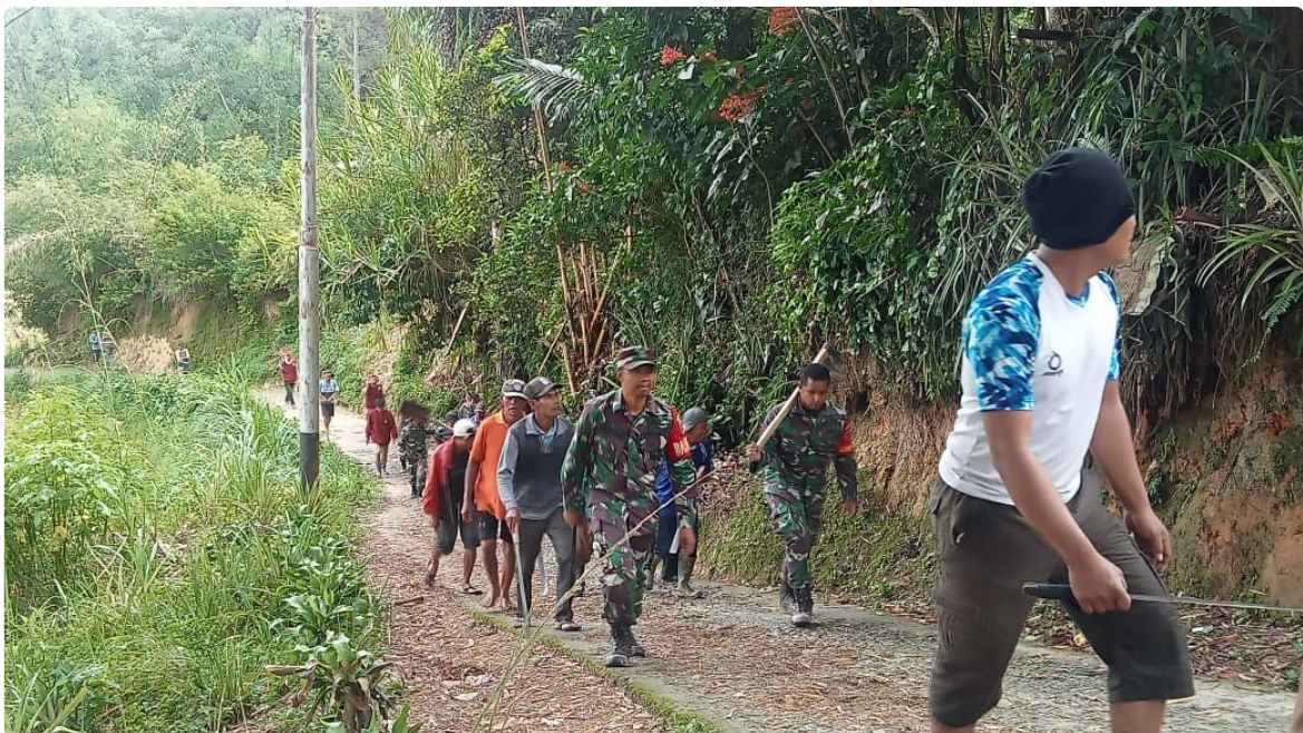
Di lokasi itu, Babinsa dan warga terlihat bersinergi membersihkan setiap area saluran irigasi yang berada di Dusun Rante Dambu. Tujuannya, ialah untuk memperlancar pengairan ke sawah warga.
